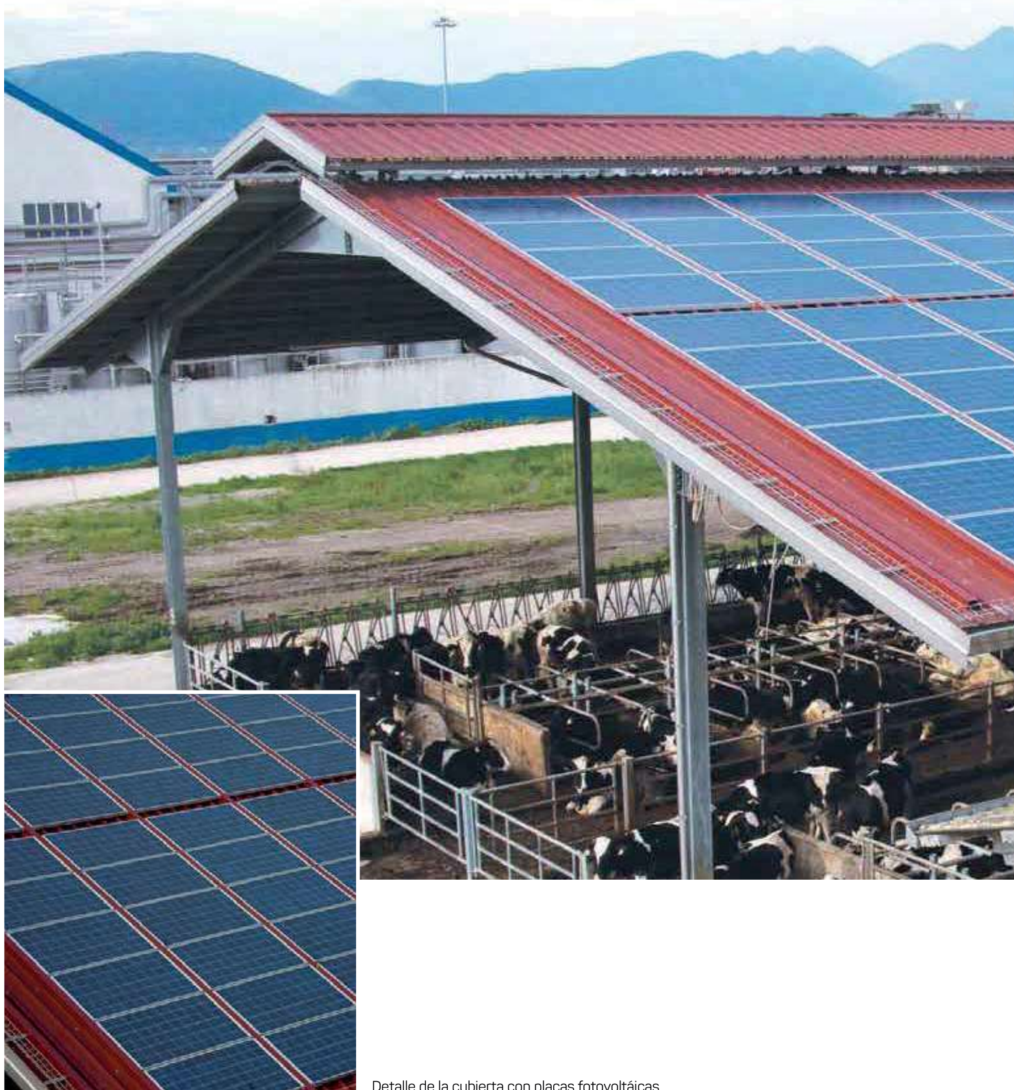
Detalle de la cubierta con placas fotovoltaicas
