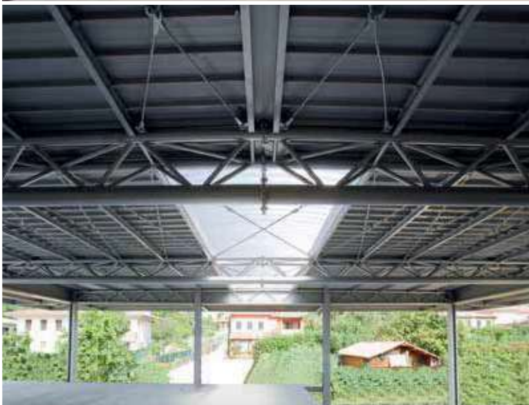
Detalle del soffito la cubierta
